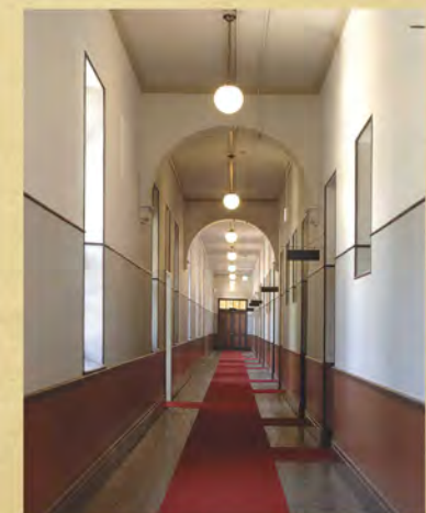
明治期の雰囲気を残す廊下 北側に廊下をおく片廊下形式で、1階は主として教員室、事務室、図書室に用い、2階は教室として使用された。
